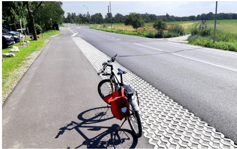
Abgrenzung zwischen Fahrbahn und Radweg: Rasengittersteine. In der Stadtgemeinde Schwechat zum ersten Mal eingesetzt.
